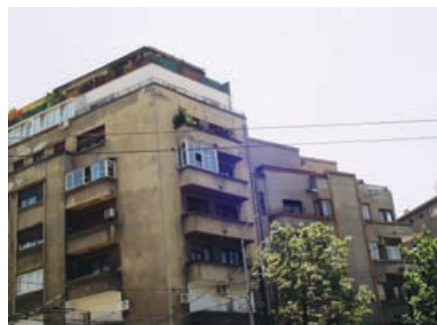
Večina blokov kliče po obnovi
